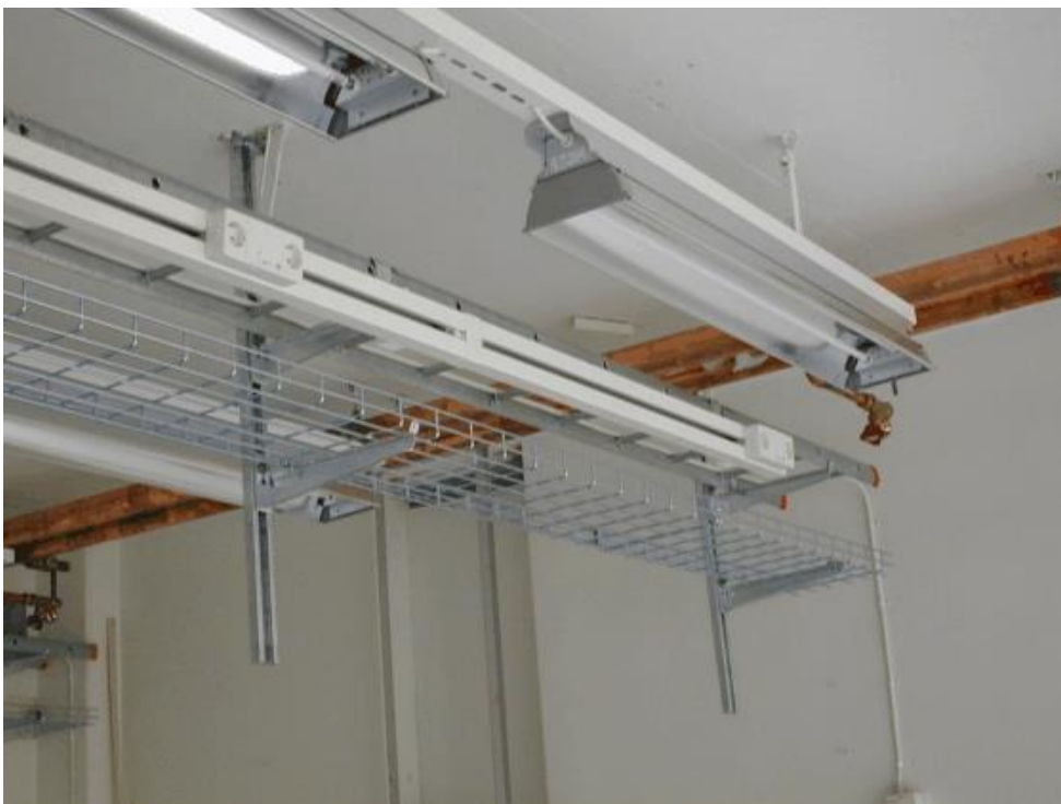
Skensystem ("KB-kanal") med pluggbara uttag
